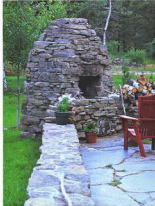
Печь для барбекю имеет штабельную конструкцию из плоских камней и расположена в углу, за пределами периметра патио
