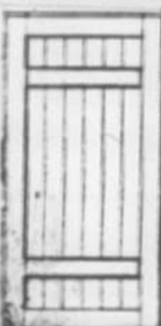
Двери из утолщ. досок, соединенных изнутри с помощью наклонных брусков из шпалов
