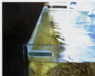
Ребра жесткости придают дополнительную прочность конструкции. Фото А. Иванова.
