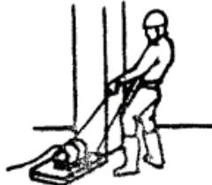
В труднодоступных местах (колонны, стояки, выгородки) бетонщик ( $B_1$ ) уплотняет бетонную смесь площадочным вибратором, затем поверхность бетона выравнивается гладилкой.
