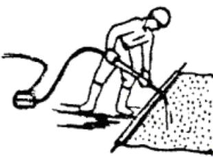
Бетонщики ( $B_2$  и  $B_3$ ) расстилают отсасывающий мат в специально отведенном месте, а бетонщик ( $B_4$ ) включает очиститель высокого давления и струей воды промывает отсасывающий мат.
