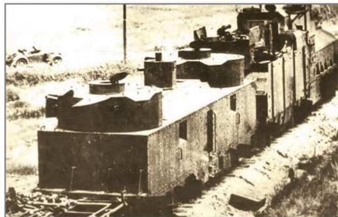
Бронеплощадка ПЛ-35 и бронепаровоз. Сзади на тендере видна бронировка зенитной установки
