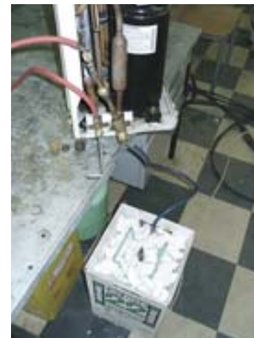
Эвакуация хладагента с помощью отвакуумированного баллона
