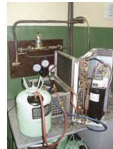
Эвакуация хладагента с помощью вакуационной станции
