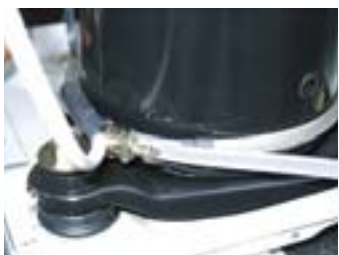
Установленный картерный нагреватель
