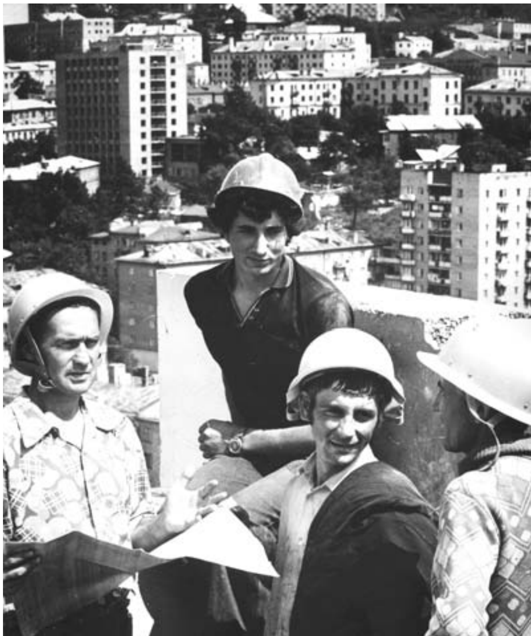
Рис. 224. В кадре применены: равномерное заполнение площади изображения, замкнутость по отраженности действия, светотеневой рисунок освещения, горизонтальная линия Хогарта, проходящая по каскам строителей. Фото В. Кладова
