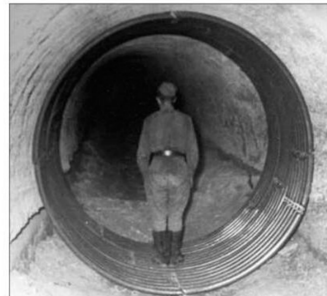
Обделка из элементов КВС-А, установленная в выработке.
