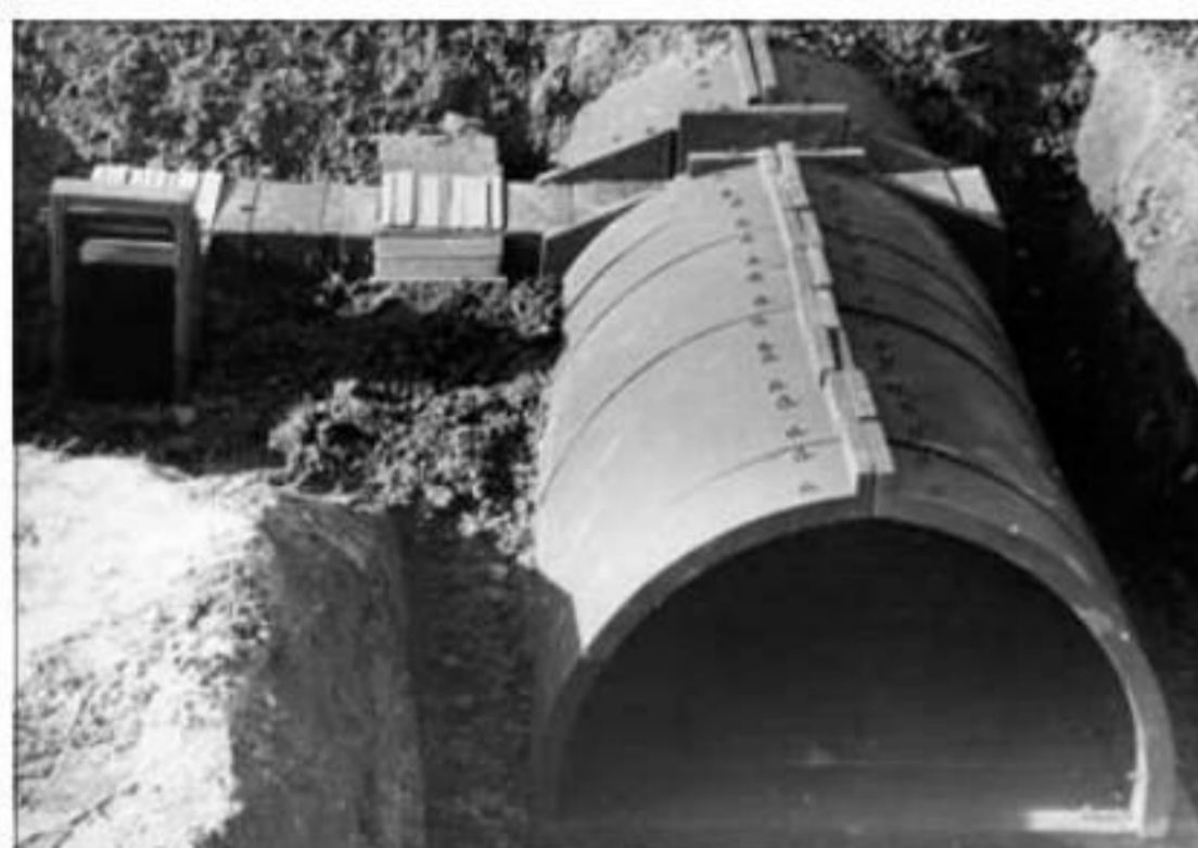
Сооружение из элементов ТБ (УСБ) в котловане.
