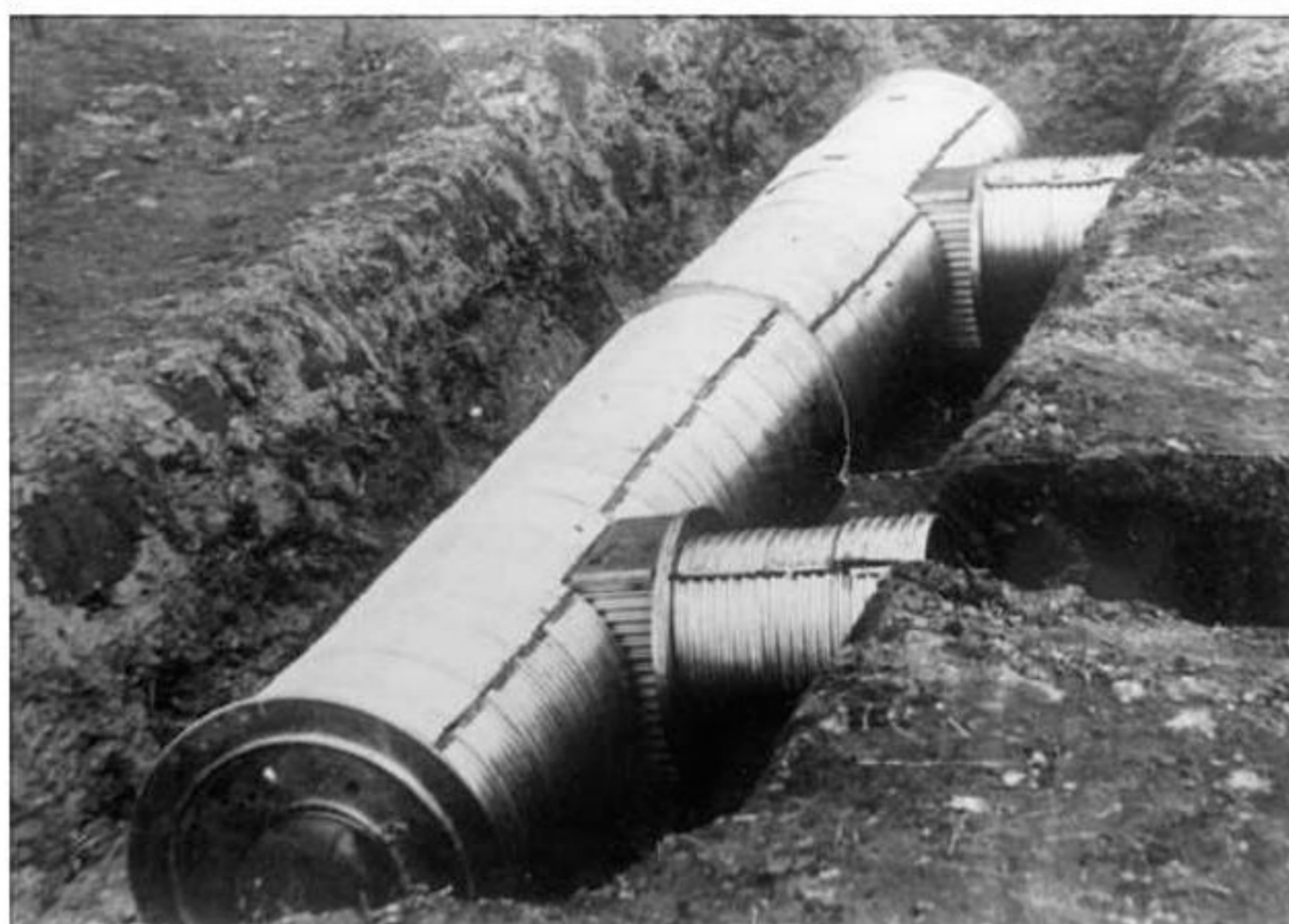
Общий вид состыкованных (в продольном направлении) сооружений КВС-А в котловане перед обсыпкой грунтом.
