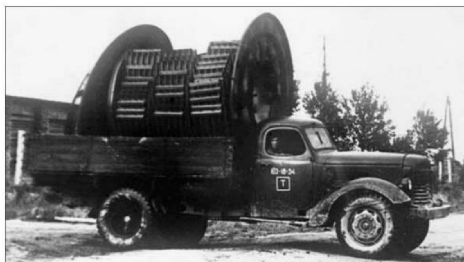
Транспортировка комплекта сооружения из волнистой стали КВС-А на автомобиле ЗИС-150.
