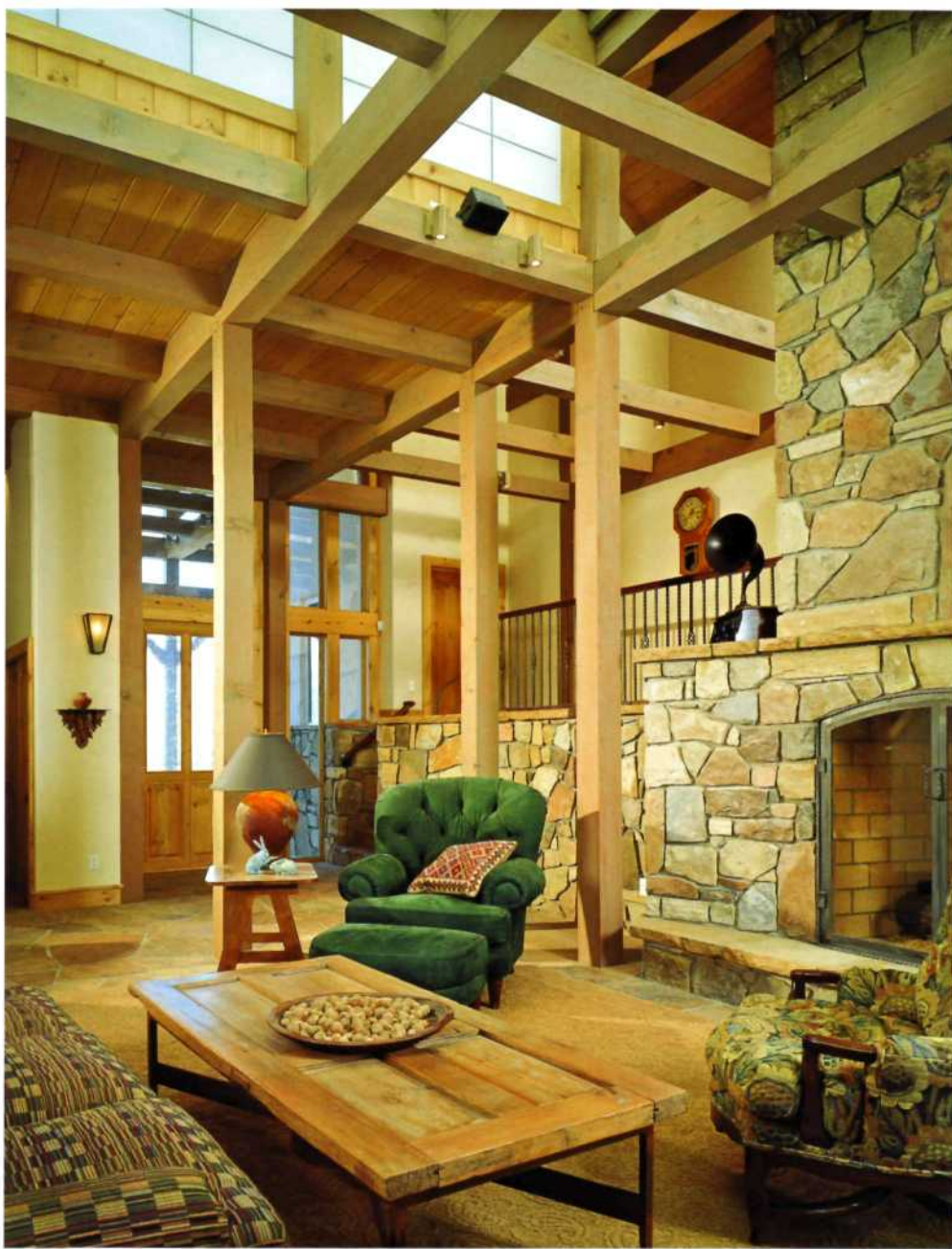
Интересный рисунок решетки из деревянных балок служит и забавной дополнительной поддержкой, и ценным конструктивным элементом дизайна дома
