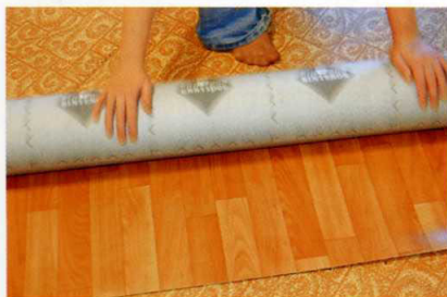
Раскладывать линолеум начинают от противоположной от окна стены, аккуратно раскручивая на себя
