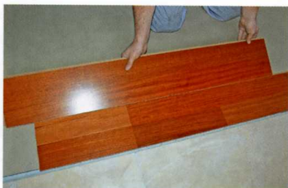
Панель второго ряда ламинированного покрытия поднести к панели первого ряда под углом 20°, вставить в замок и защелкнуть
