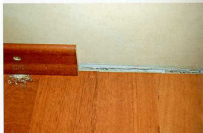
По окончании укладки ламината прикрепить плинтус
