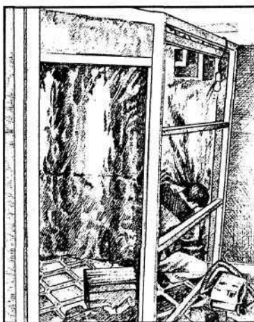
3-й этап. Тепло- и пароизоляция парилки
