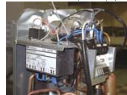
Фото 6. Так выглядит полностью смонтированный регулятор
