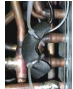
Фото 5. Дополнительная теплоизоляция повышает точность показаний сенсора
