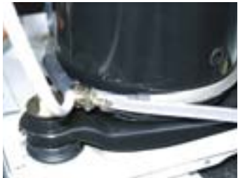
Установленный картерный нагреватель
