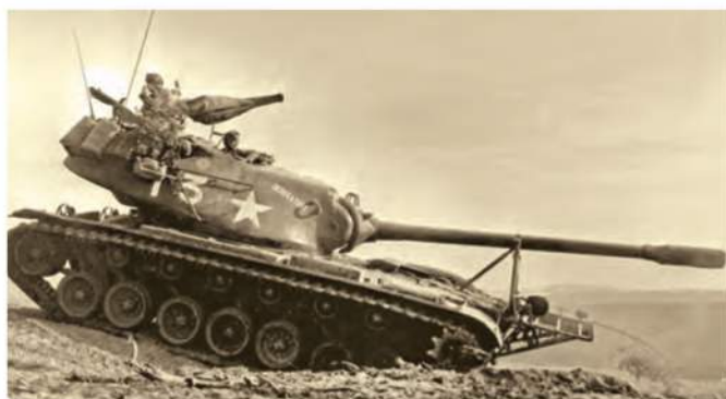
М103 из состава 2-го тяжелого танкового батальона 7-й американской армии в Германии. На корме танка укреплен платформ для дополнительных топливных емкостей
