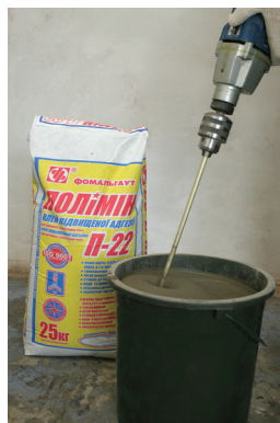
Рис. 11. Перемішування клею за допомогою низькообертового дреля з насадкою
