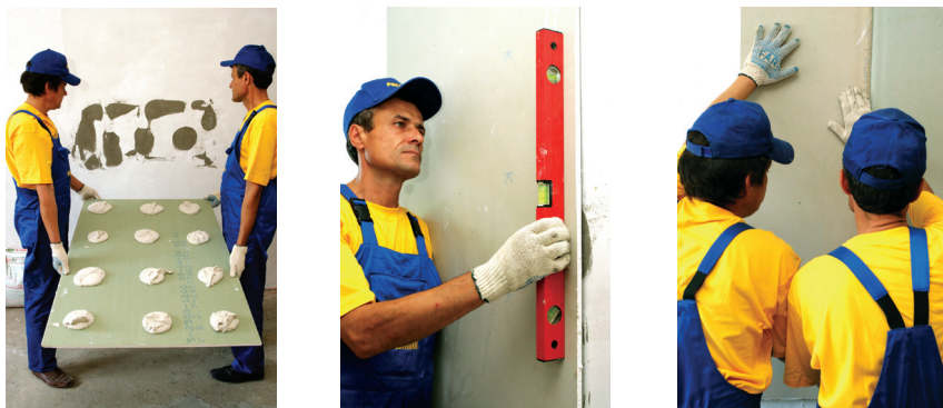
Рис.26 Техніка влаштування облицювального покриття з ГКП
