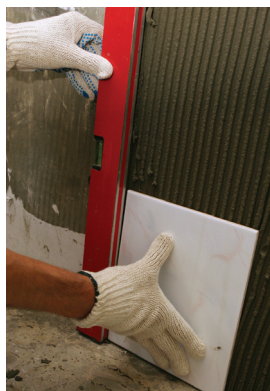
Рис. 15. Притулення та притиснення плитки до основи
