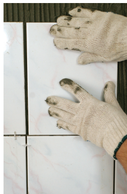
Рис. 16. Встановлення наступної плитки
