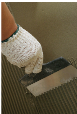
Рис. 13. Розгладжування нанесеної клейової суміші зубчастим шпателем: а) по стіні; б) по підлозі
