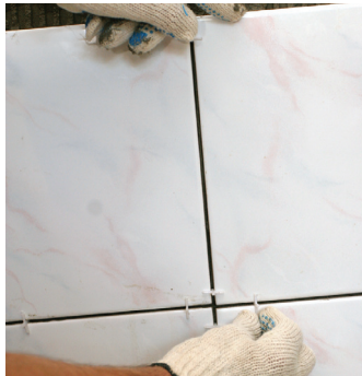
Рис. 21. Облицювання прямокутної підлоги площею до 4 м 2 :
