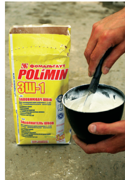
Рис. 27 Приготування маси для заповнення швів
