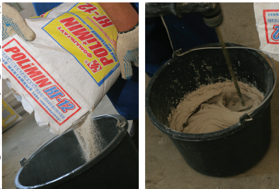
Рис. 24 (а, б). Техніка приготування розчинової клейової суміші КГ-12
