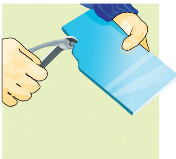
Рис. 8. Відламування шматка плитки криволінійного окреслення
