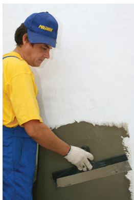
Рис. 12. Нанесення клею на поверхню за допомогою широкого шпателя
