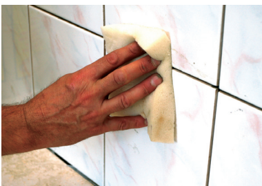
Рис.28 Зволоження поверхні плиток перед заповненням швів
