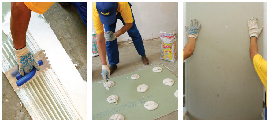
Рис. 25 (а, б, в). Способи нанесення клею на ГКП (а, б) та її притиснення до стіни (в)
