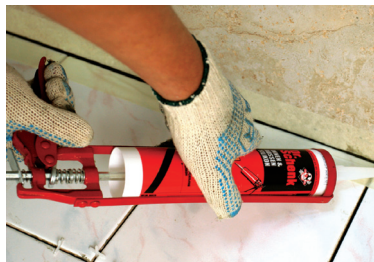
Рис. 30 Заповнення деформаційного шва силіконовим герметиком
