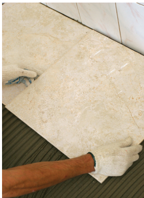
Рис. 20 (а, б). Укладання (а) та коригування (б) великих плит на підлозі
