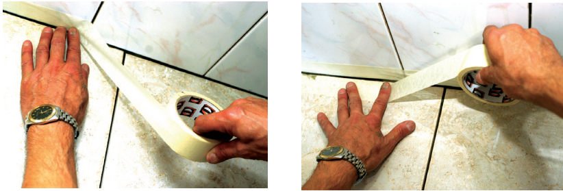
Рис.31 Заклеєння кромки шва а) - стіни, б) - підлоги самоклеювальною стрічкою
