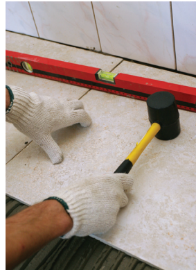
Рис. 20 (а, б). Укладання (а) та коригування (б) великих плит на підлозі
