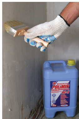
Рис. 5. Грунтування емульсією групи АС
