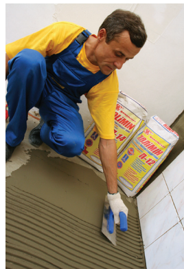
Рис. 13. Розгладжування нанесеної клейової суміші зубчастим шпателем: а) по стіні; б) по підлозі
