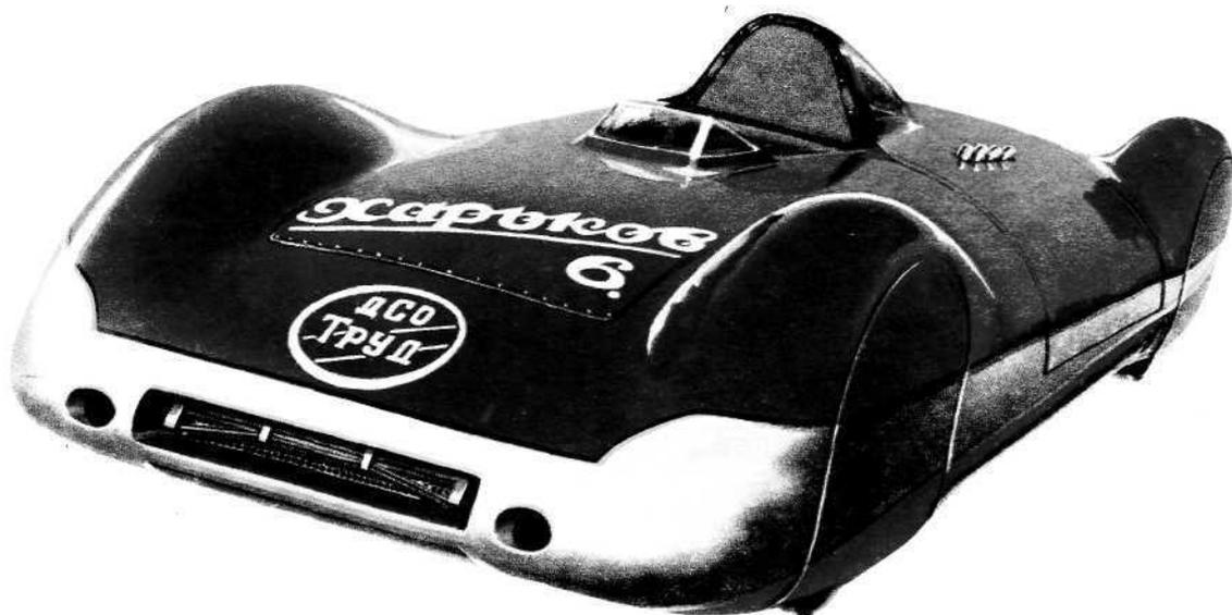
**«Харьков-6» с двигателем «Победы», имевшим два верхних распределительных вала. 1952 г.**
