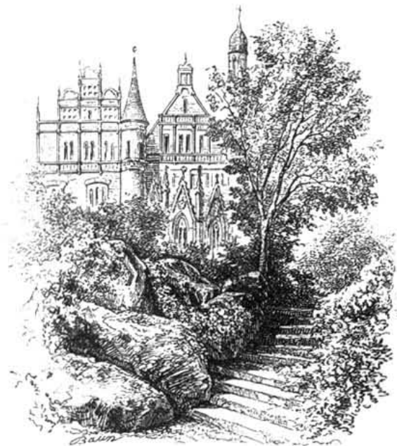
Часть южнаго фасада замка съ церковью.
