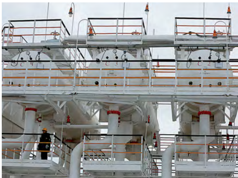
УСТАНОВКА ПРЕДВАРИТЕЛЬНОГО СБРОСА ВОДЫ НА ДНС-3Н. Фёдор Савинцев
