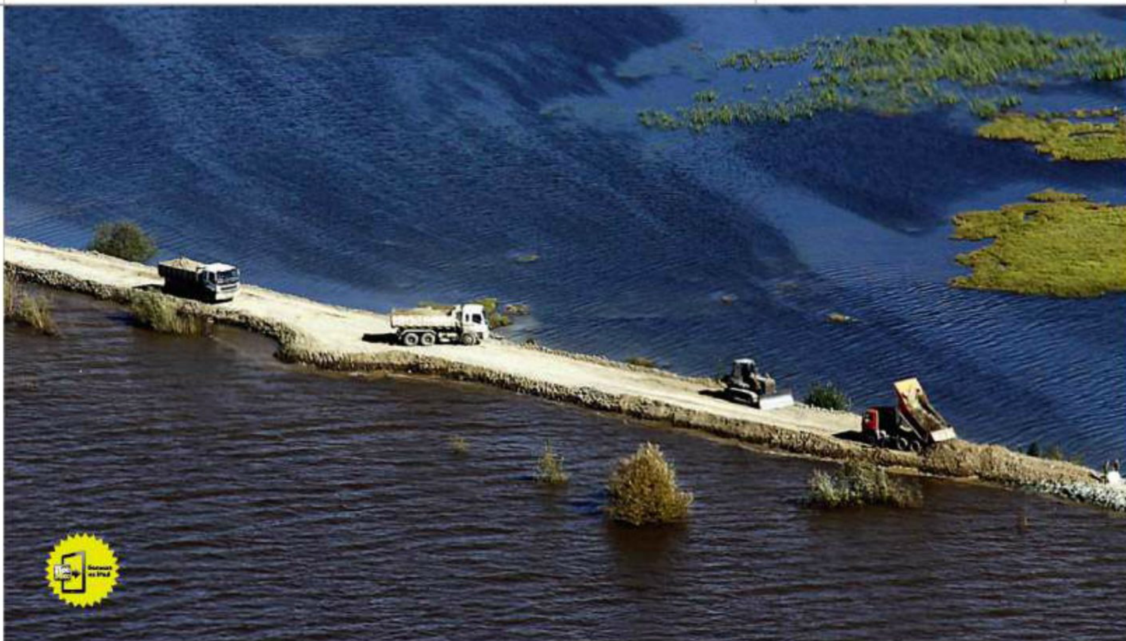
Сентябрь 2013 года. Ведутся ремонтно-восстановительные работы на Мылкинской дамбе (Комсомольск-на-Амуре). Вода начала перехлестывать через дамбу, и под угрозой затопления оказались центральные районы города. Защитное сооружение пришлось нарастить.
